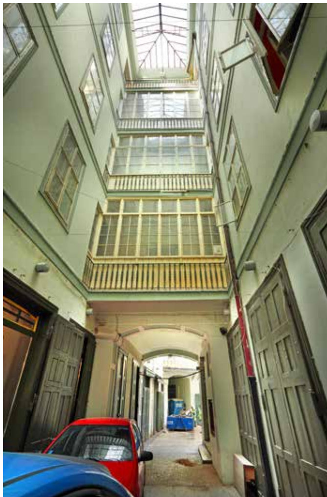
Rekonstrukce bytových domů Havelská 27
