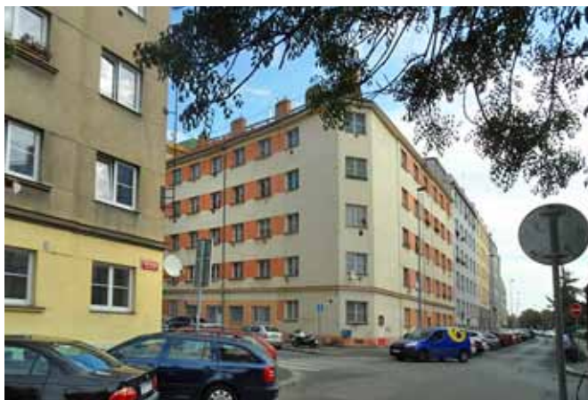
Bytový dům na ulici Přípotoční, Praha 10
