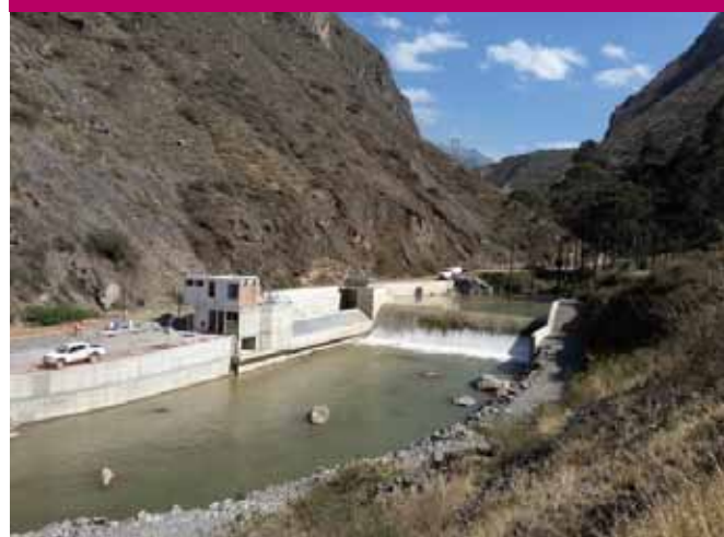
Bocatoma – vtokový objekt do 11 km privádzača k vodnej elektrárni. Aj tu sú štyri naše stavidlá
