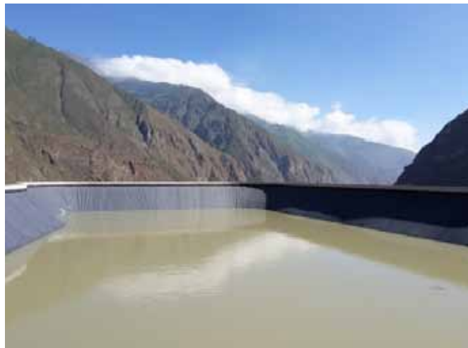
Rapacan – nádrž pre denné vyrovňovanie prietokov. To čierne po obvode nádrže nie je asfalt, ale záhradná fólia. V podstate je to také väčšie záhradné jazierko vo výške 2700 m.n.m.
