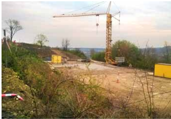
Příprava na stavbu rodinných domů v Radotíně
