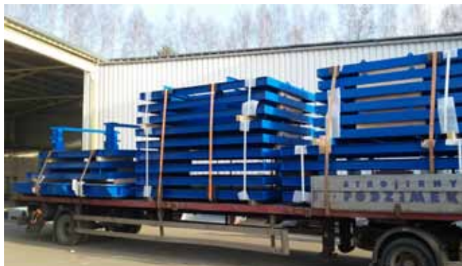
Odvoz ocelových podlahových dílů na montáž do Chvaletic
