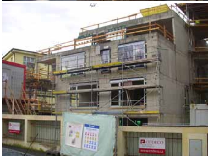
Zahájení stavby na Ville Atrium Bubeneč
