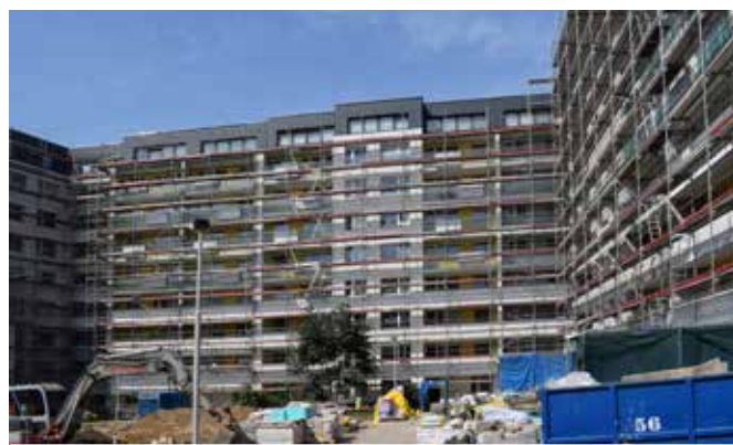
Rekonstrukce panelových domů v Praze 3
