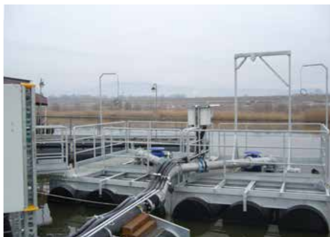
Nová čerpací stanice
