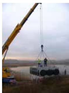
vlevo Instalace nové čerpací stanice na odkališti vpravo Stará čerpací stanice
