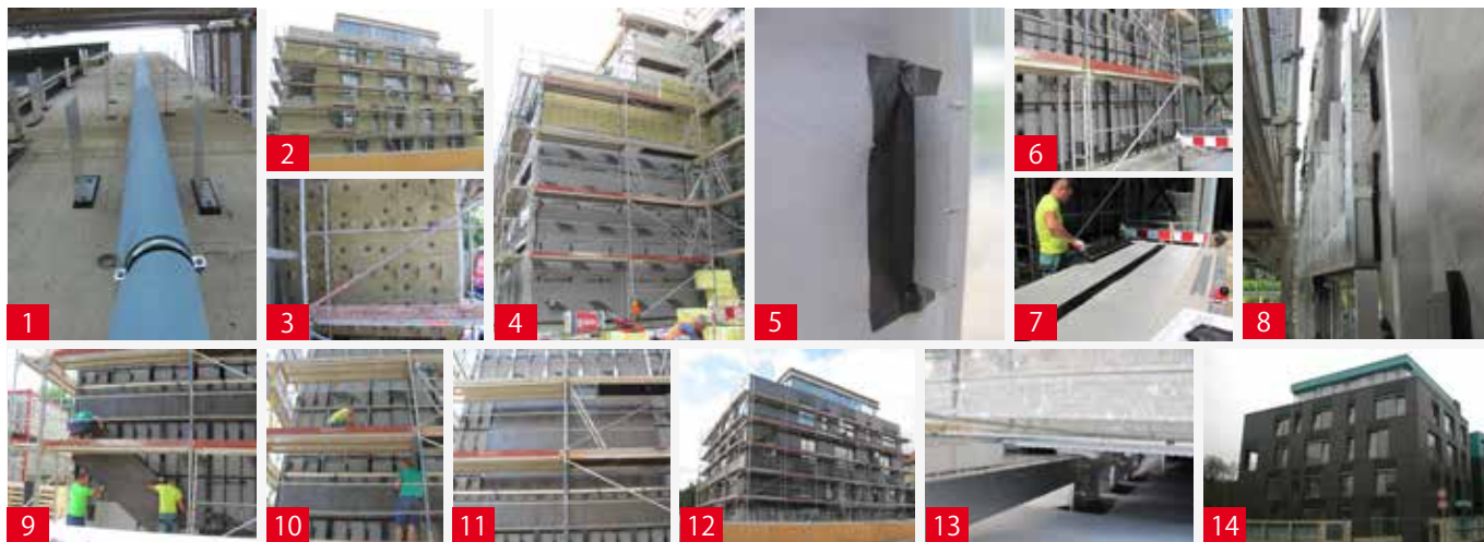
1) Al kotvy včetně tepelně-izolačních podložek 2) montáž tepelné izolace 3) kotvení tepelné izolace 4) montáž difuzní folie 5) přelepení prostupu-kotvy 6) penetrování svislých nosných Al profilů 7) penetrování keramické desky 8) svislé nosné Al profily 9) lepení keramických desek 10) aplikace lepidla na svislý nosný Al profil 11)12) lepení keramických desek 13) detail nalepení keramické desky - distanční páska + lepidlo 14) finální fasáda
