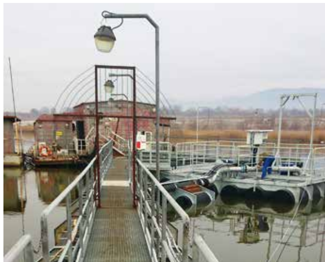
Celkový pohled na starou čerpací stanici (vlevo) a novou čerpací stanici
